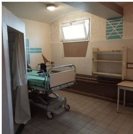
Cellule PMR au bâtiment C
