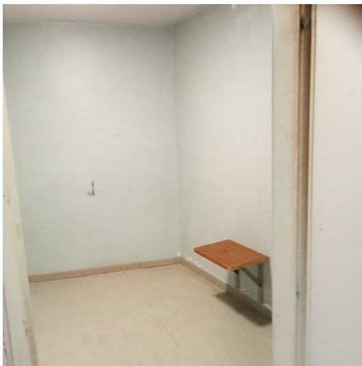
Local de fouille bâtiment B
