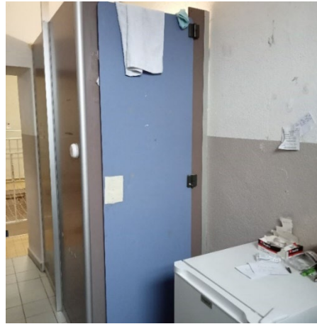
Cloison des WC cellule du bâtiment A
