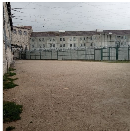
Cour de promenade bâtiment A
