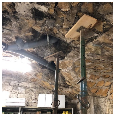
Lieu de stockage au sous-sol de la cuisine
