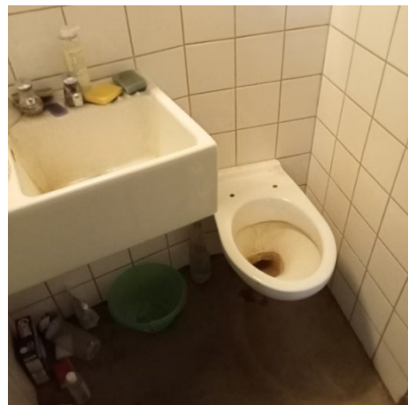
Sanitaires de cellule du bâtiment B
