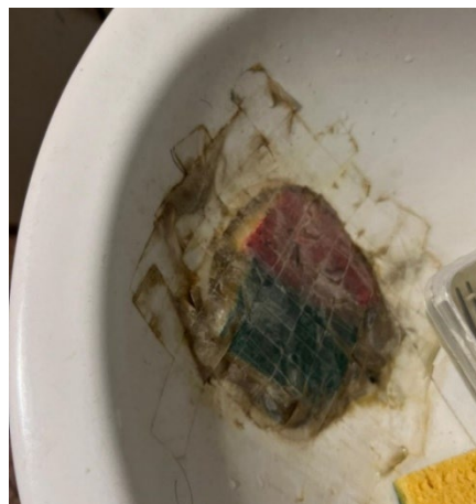
Trou dans un lavabo cellule bâtiment C
