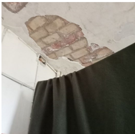
Plafond de cellule au bâtiment C
